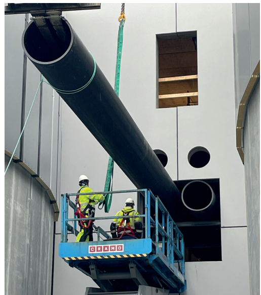
Installasjon av 800 mm SDR 26 rør fra tankene til den første avdelingen.
