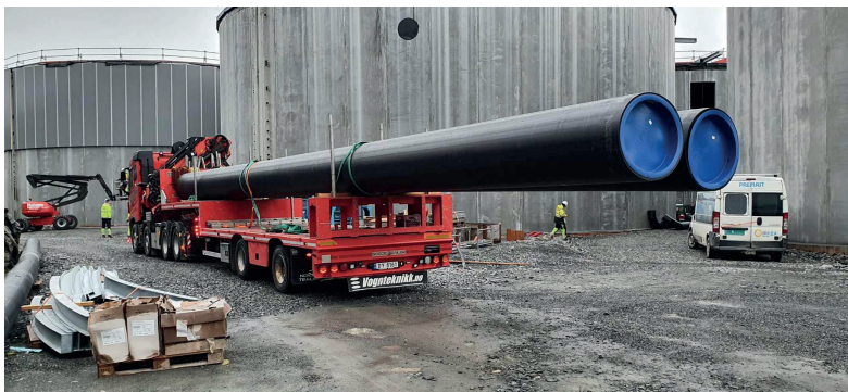
Transport av PE 100 rør på anlegg.
