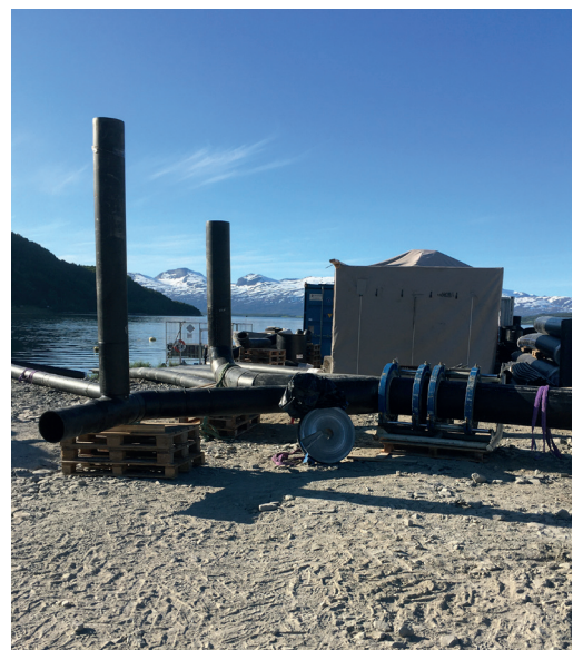
Prefab / Sveising på stedet, tilførselsrør til DPT6 underjordisk.
