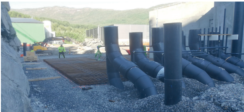
Rør i grunn, under gulvnivå, RAS DPT6
