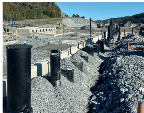
Pågående arbeid med rør under bakke.
