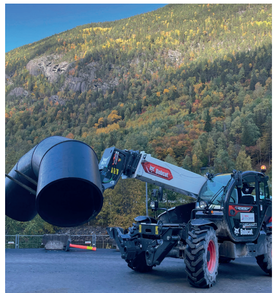
Transport av rør på anlegg
