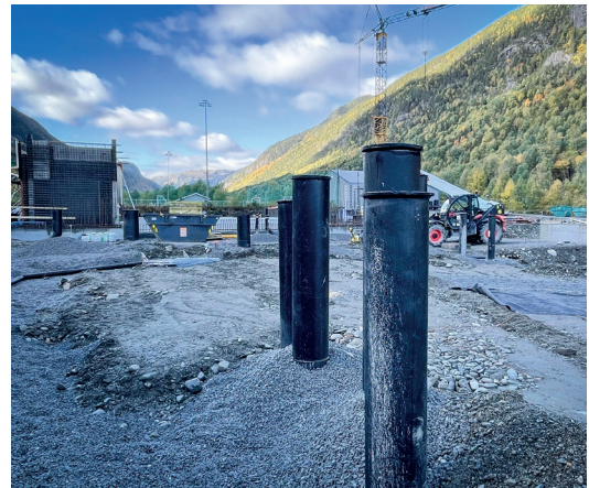
Rør under bakke pågående
